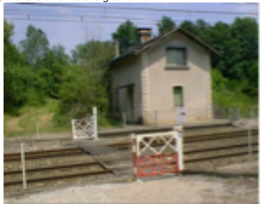
Figure 5 : passage à niveau piéton avec portillon
