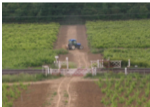
Figure 6 : passage à niveau privé
